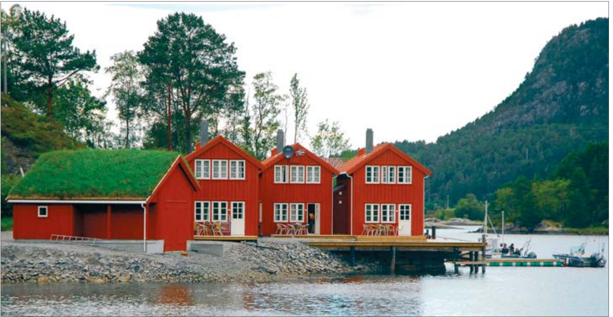
Tre leiligheter på rekke og rad langs bryggekannten i Møst har erstattet den gamle brygga.
